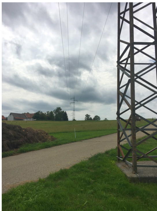
Abb. 3: Mast 15 - Richtung Mast Lage
